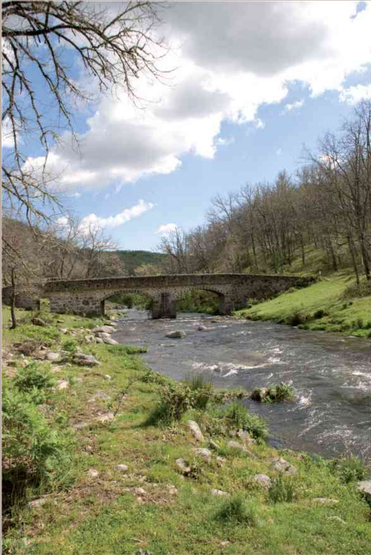
Entorno ribereño con el puente al fondo
