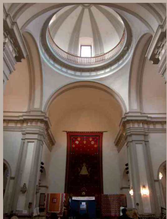
Cúpula del transepto
