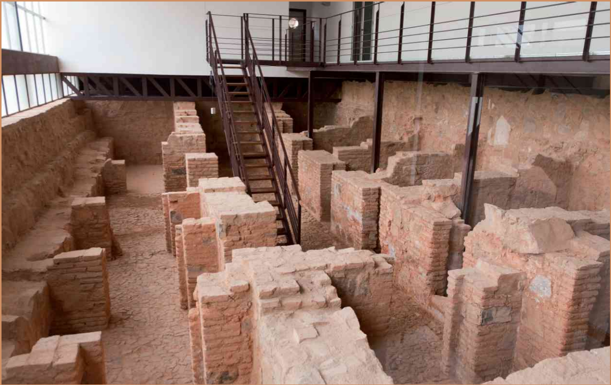
Celdas y pasadizos de la antigua Cárcel de Forzados. Declarado Bien de Interés Cultural
