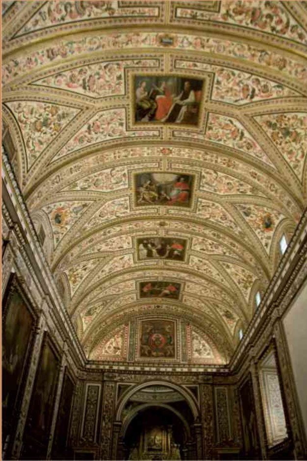
Detalle de la bóveda de la sacristía
