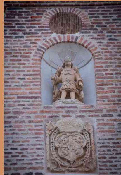
Hornacina donde se ubica el arcángel San Rafael (fachada)
